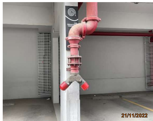
รูปที่ 2-27 หัวรับน้ำดับเพลิงภายนอกอาคาร
